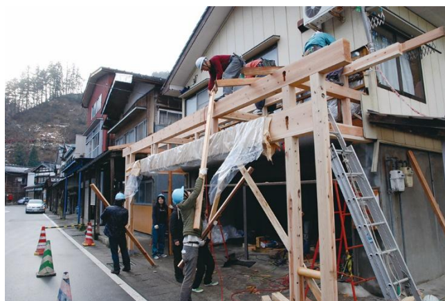
長岡市栃尾での雁木建設
