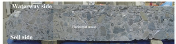
図1 凍害損傷が顕在化した鉄筋コンクリート部材(水利施設)
