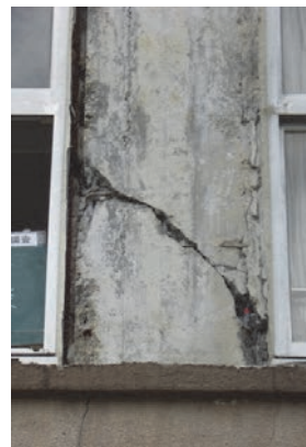
被災したS小学校の柱(左)
