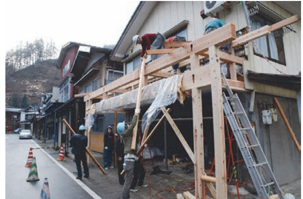
長岡市栃尾での雁木建設
