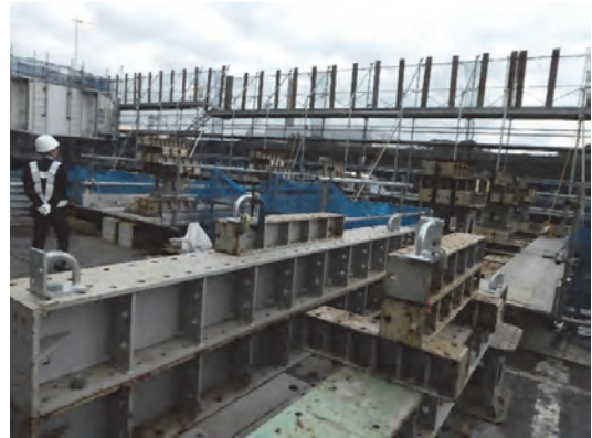
首都高速道路1号羽田線東品川栈橋鮫洲埋立部更新工事の現地視察より(中東による撮影)
