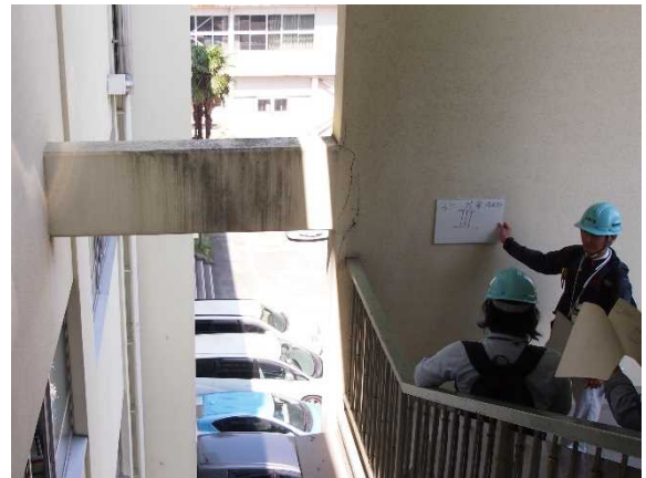
2016年熊本地震の被害調査
