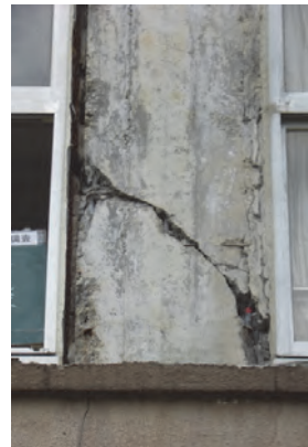
被災したS小学校の柱(左)
