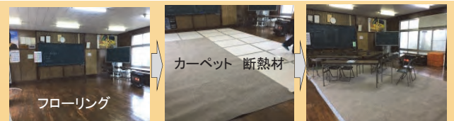
カーペット 断熱材 床面に断熱材とカーペットを敷設
