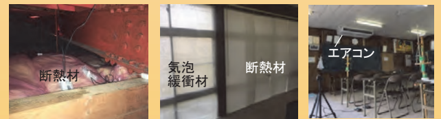
断熱材 気泡緩衝材 断熱材 エアコン 小屋裏に断熱材を敷設 窓面の断熱性能の向上 エアコンの設置
