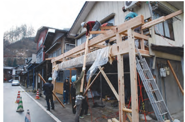
長岡市栃尾での雁木建設
