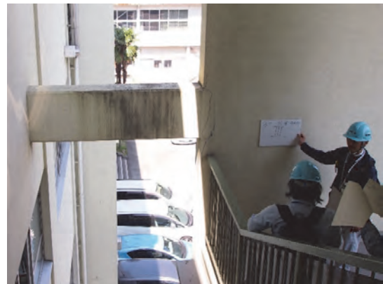
2016年熊本地震の被害調査
