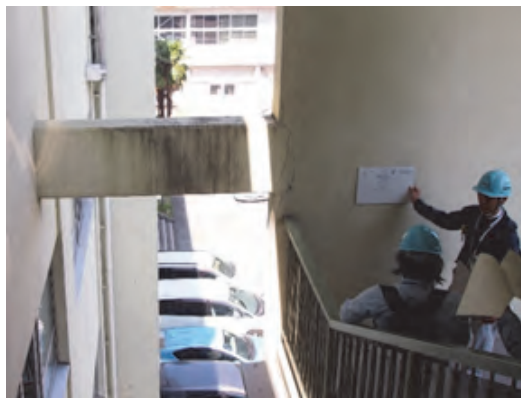
2016年熊本地震の被害調査
