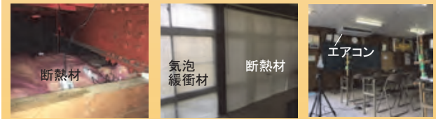
小屋裏に断熱材を敷設 窓面の断熱性能の向上 エアコンの設置
