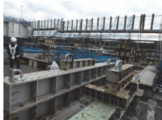
首都高速道路1号羽田線東品川橋脚洲埋立部更新工事の現地視察より(中東による撮影)
