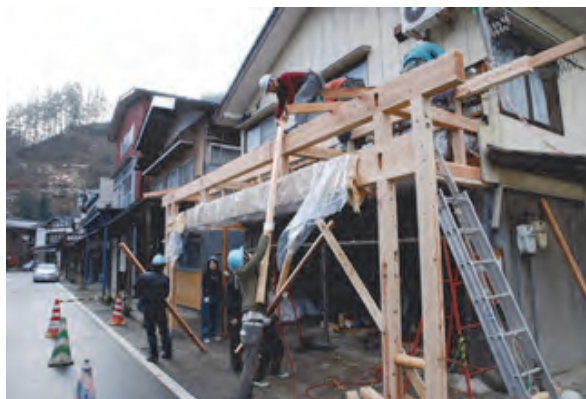
長岡市栃尾での雁木建設
