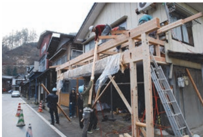
長岡市栃尾での雁木建設
