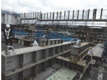
首都高速道路1号羽田線東品川棧橋鮫洲埋立部更新工事 の現地視察より(中東による撮影)
