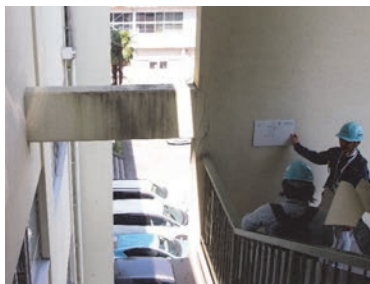
2016年熊本地震の被害調査
